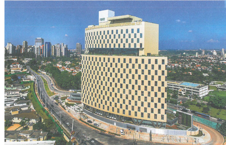
1 No Colégio Roberto Herberster Gusmão, em Minas Gerais, foram utilizados revestimentos em concreto polímero, com grandes dimensões e sem elementos de fixação aparentes / 2 A fachada ventilada do edifício sede da Bradesco Seguros, composta por painéis cerâmicos, emprega ainda pele de vidro e brises metálicos
